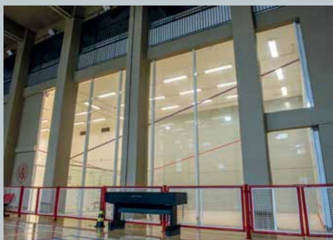
Pilares reforçados e quadra de squash, liberada para uso
