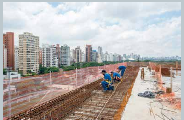
Laje do Prédio Novo terá bar e quadras
